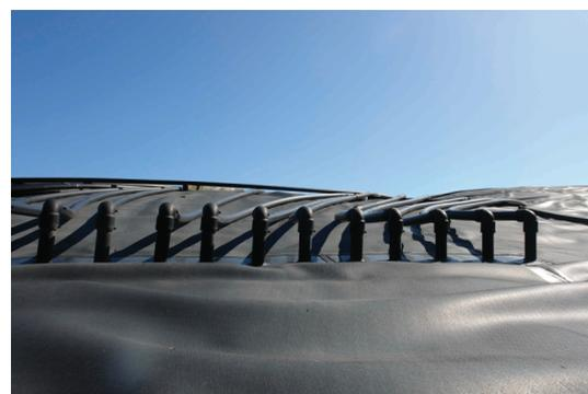
**Abbildung 2:** Infiltrationsvorrichtung auf der Leppe-Deponie
