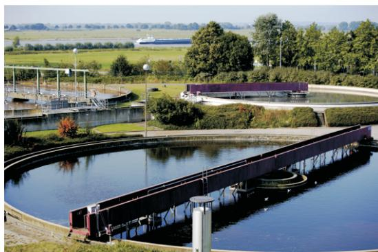
Abbildung 1: Kläranlage Emmerich; im Vordergrund die Nachklärbecken
