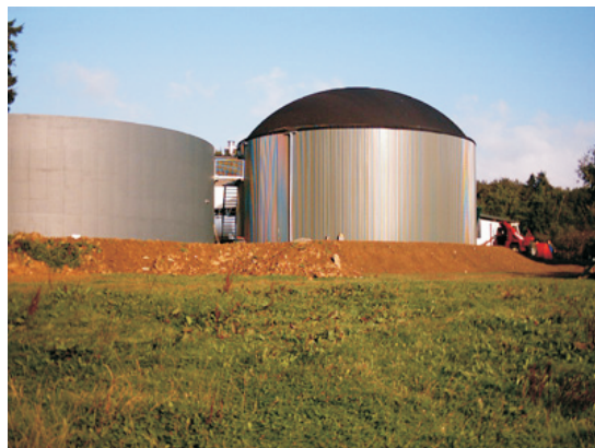
Abb.1: Herkömmliche landwirt. Biogasanlage
